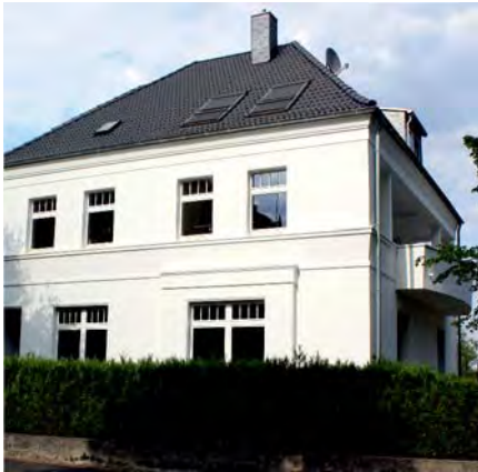
Renoviertes Wohnhaus in der Schnütgenstraße 13
