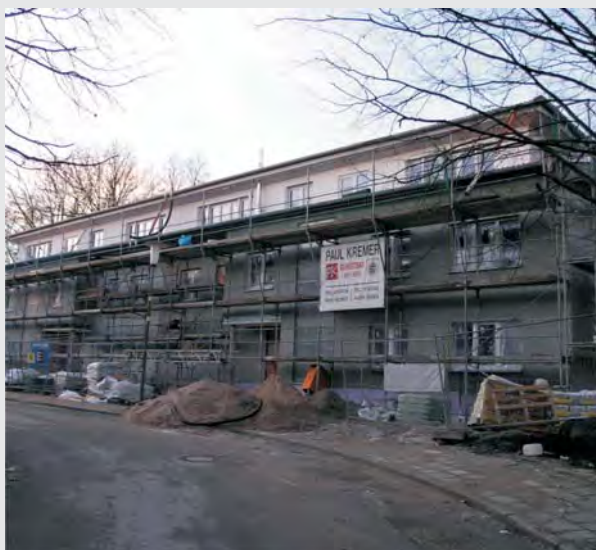
Bauvorhaben Allbau Woldrüggen, Steele
