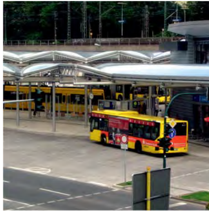
Der neue Steeler Bahnhof. Ein Zeitspiegel-Bericht über den Umbau auf den Seiten 8 und 9
