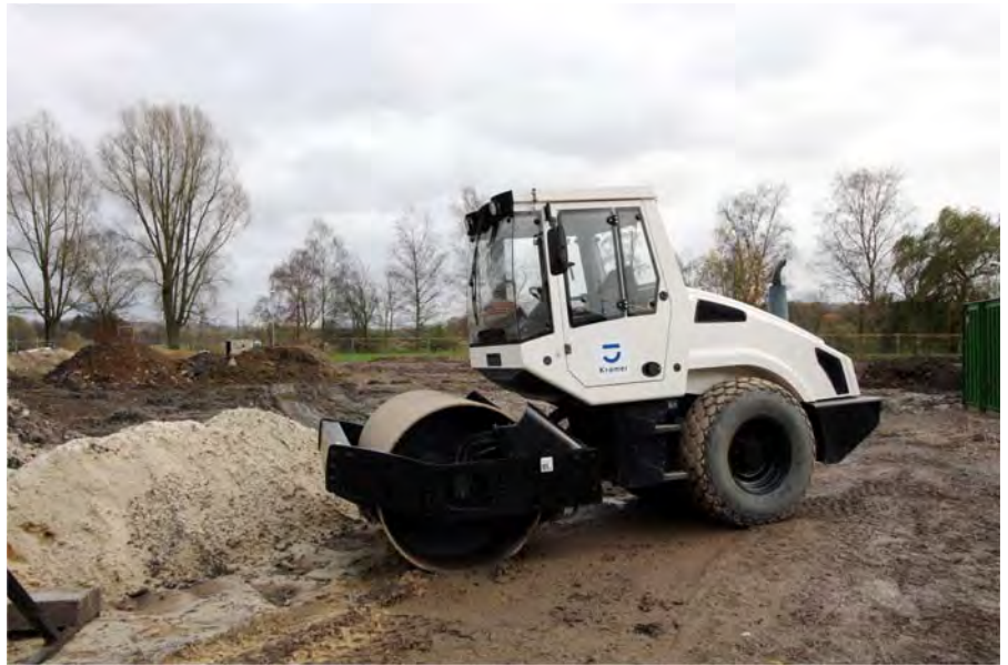
An der Westfalenstraße rollen die Bagger. Die gesamte Bauzeit ist mit rund drei Jahren veranschlagt.
