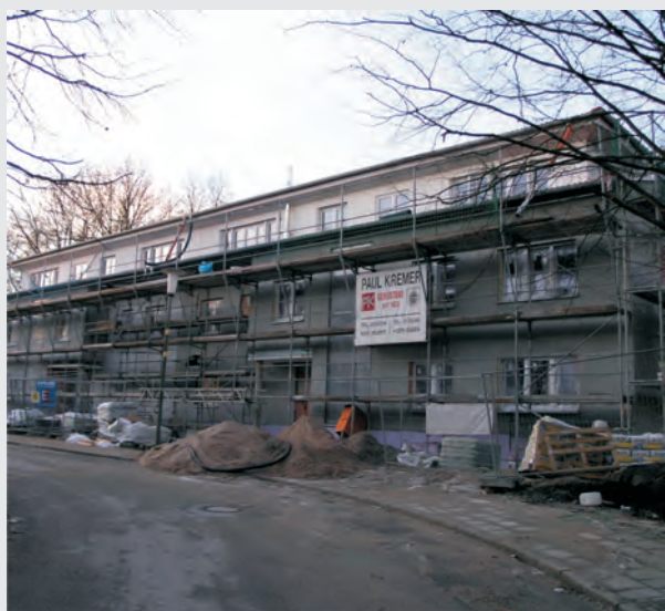
Bauvorhaben Allbau Woldrüggen, Steele
