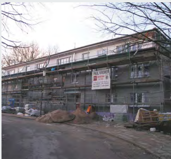
Bauvorhaben Allbau Woldrüggen, Steele
