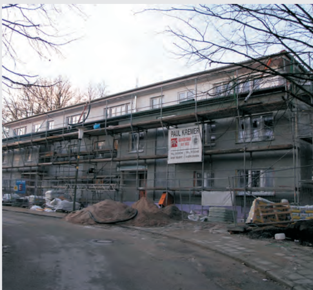
Bauvorhaben Allbau Woldrüggen, Steele
